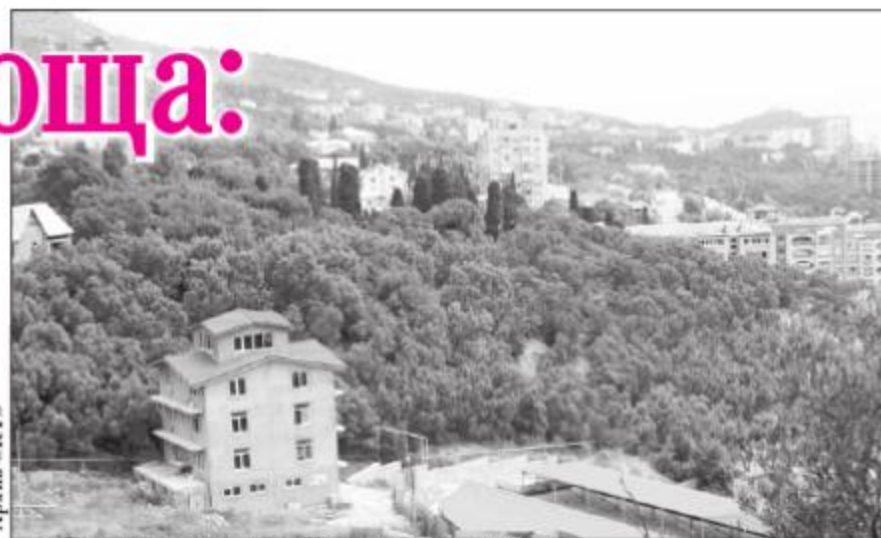
В роще провели канализацию для будущих коттеджей
